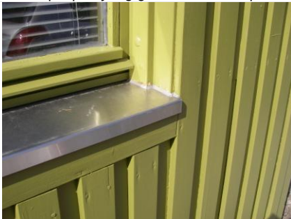
Eksempel på udbedring af sålbænk.
