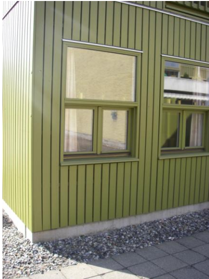
Gammelt indadgående vindue
